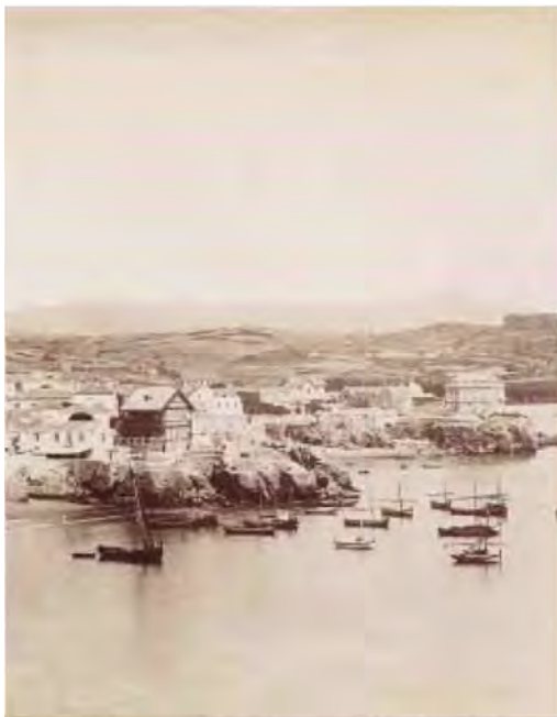
Vers 1890, Cascais avec le palais du roi Don Carlos. BY
